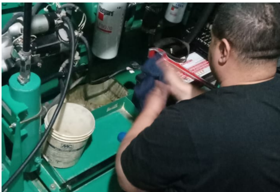
Gerador em processo de manutenção
